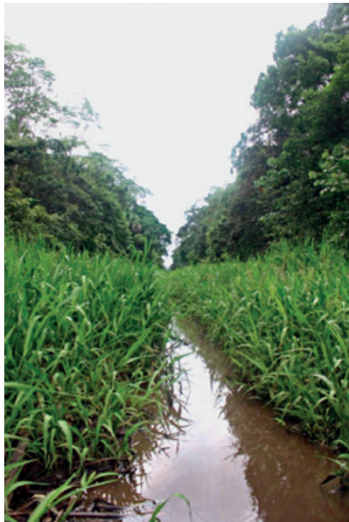
Foto 1. Oleoducto Norperuano completamente sumergido bajo agua y sin atención por la vegetación que se forma. Fuente. Monitoreo ACODECOSPAT, 2018.
