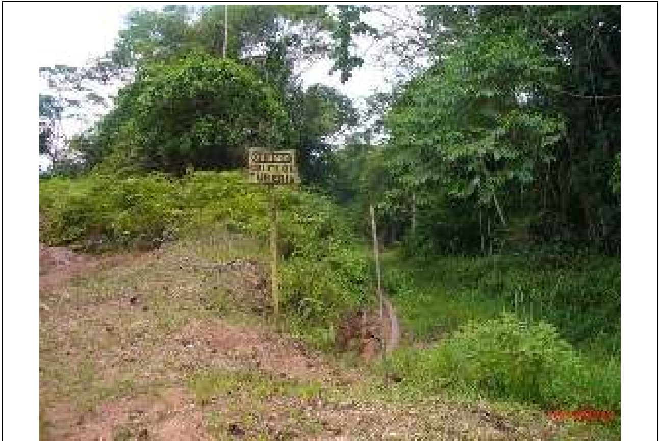
FOTO 7. Vista de la línea de flujo del Pozo CN08 donde fue cambiado parte del tramo de la tubería.
