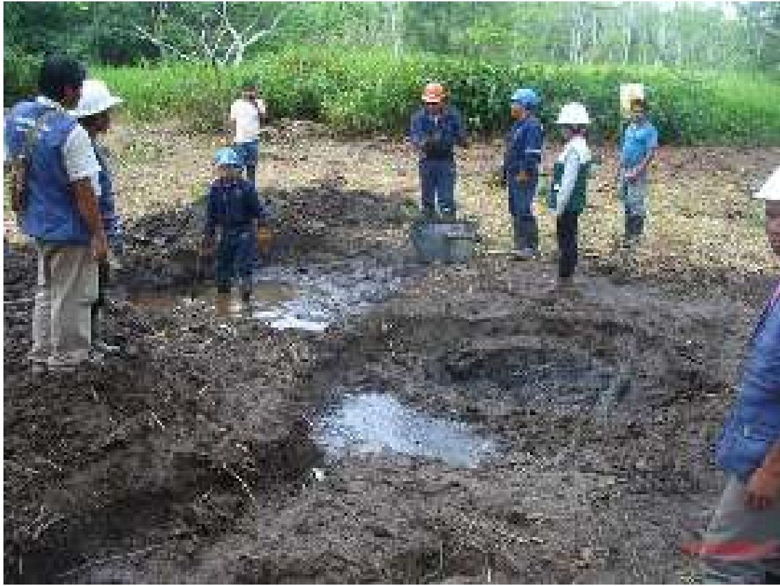
FOTO 37. Vista de otro sitio contaminado denunciado por la FEDIQUEP se observa presencia de sustancias oleosas. Personal de la empresa CORPESA, contratista de PLUSPETROL se encuentra retirando material contaminado.
