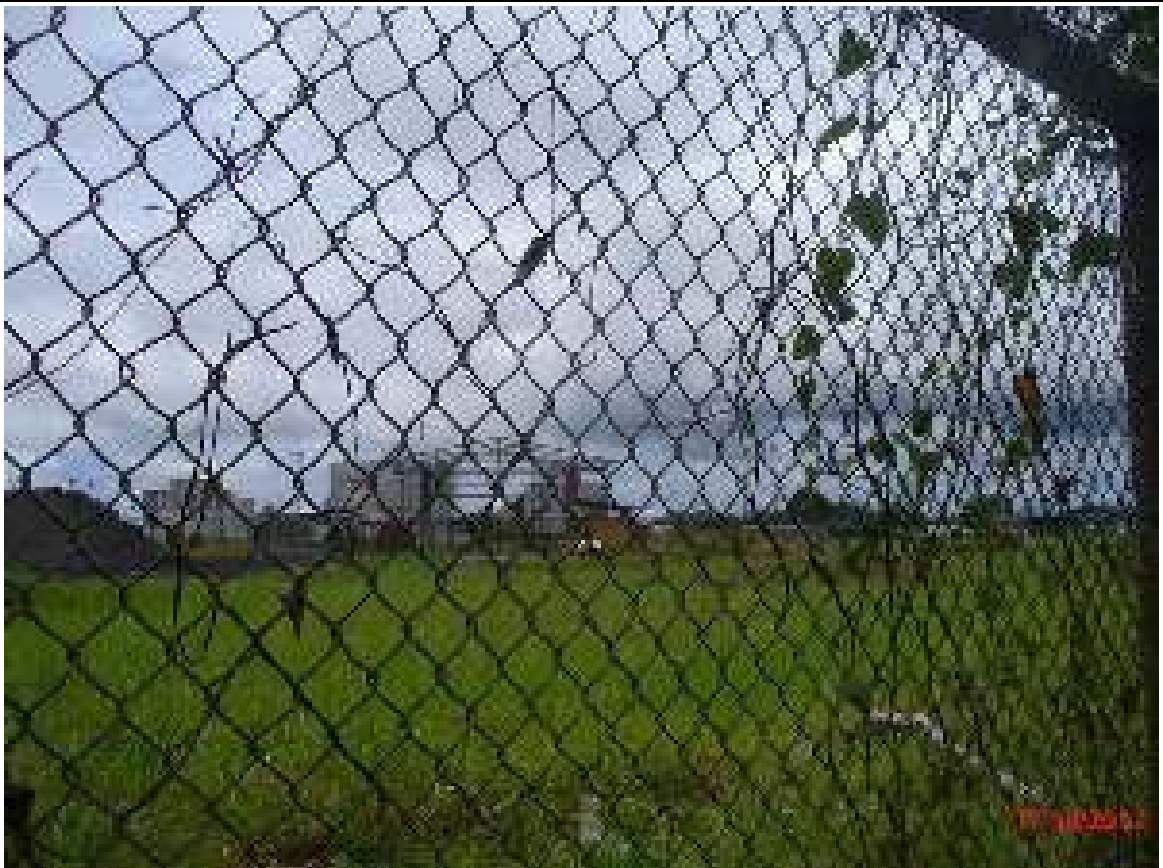
FOTO 32. Vista de las instalaciones de PLUSPETROL Lote 1-AB Andoas.
