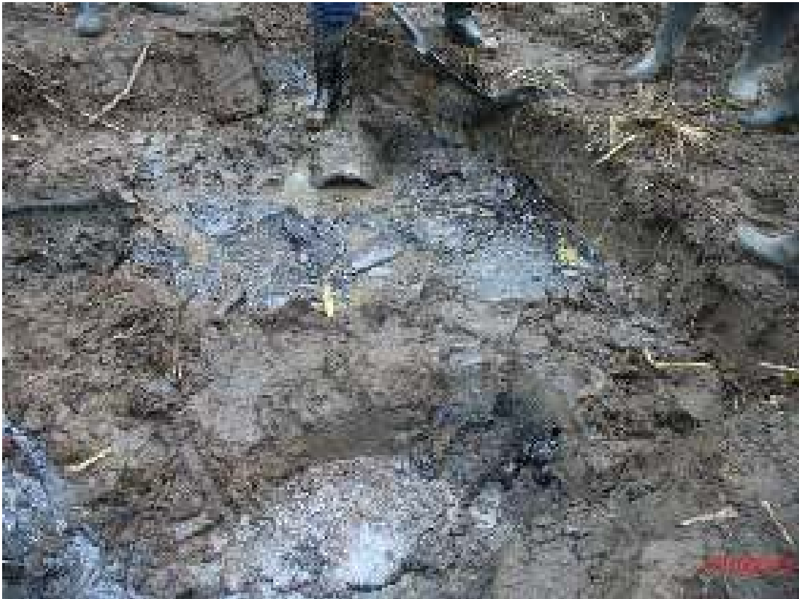
FOTO 38. Vista de una tubería abierta de donde salen sustancias oleosas con grumos que continúan contaminando la zona.
