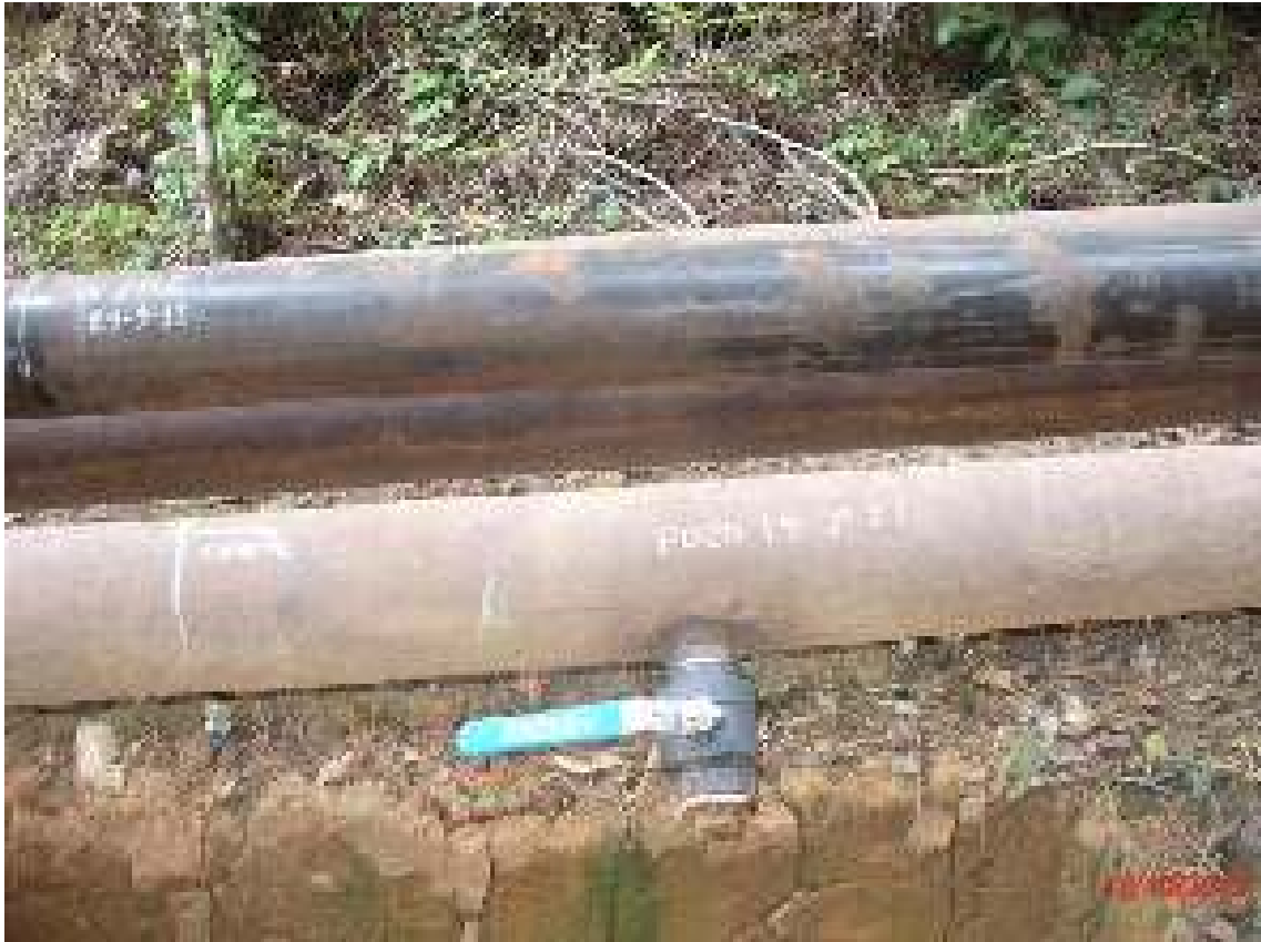
FOTO 23. Vista de la línea de flujo del Pozo CS 20 de reinyección del agua de producción con una válvula de 2'0" y una tubería nueva para el cambio de tramo.
