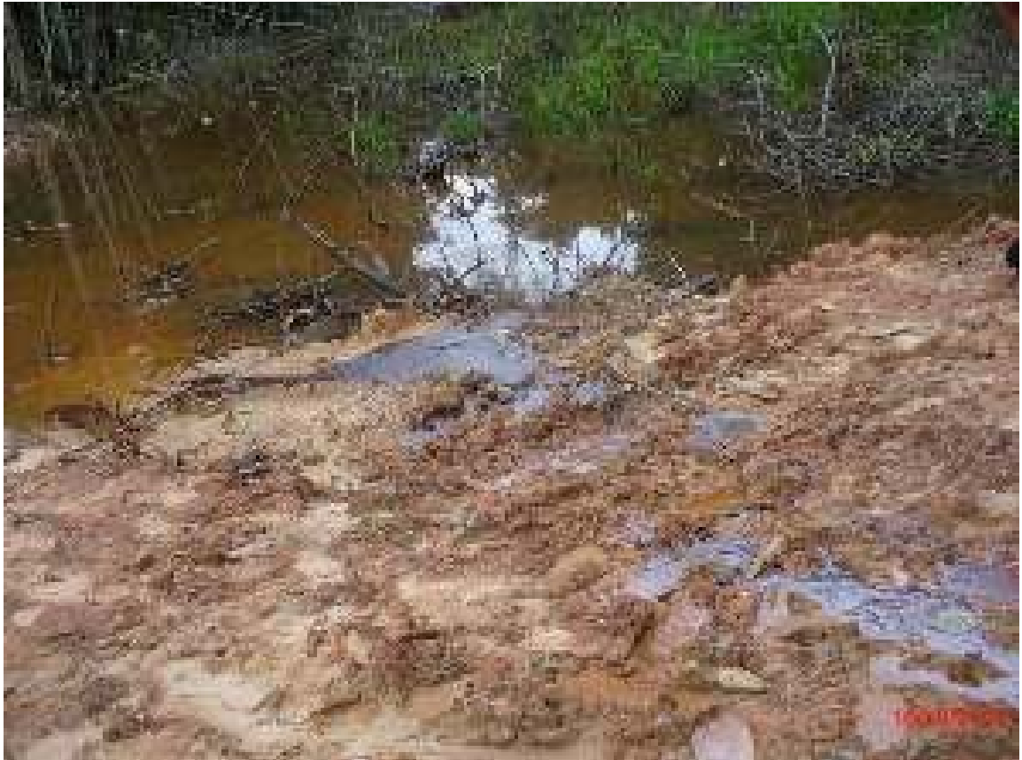
FOTO 17. En esta vista se observa el afloramiento de sustancias oleosas en el área de la quebrada donde están mezclando la tierra arcillosa, al caminar se hunde el terreno saliendo sustancias oleosas de las profundidades
