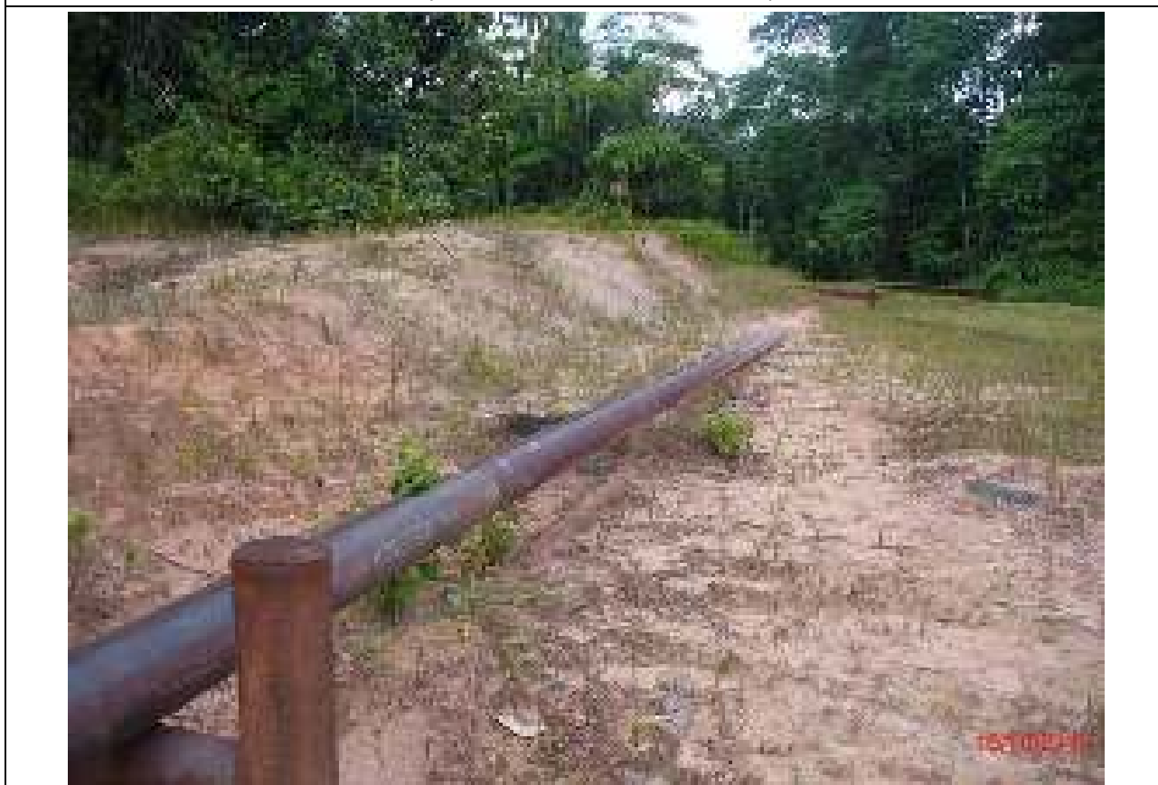
FOTO 8. Vista del otro extremo de la tubería cambiada sin protección de pintura contra la corrosión
