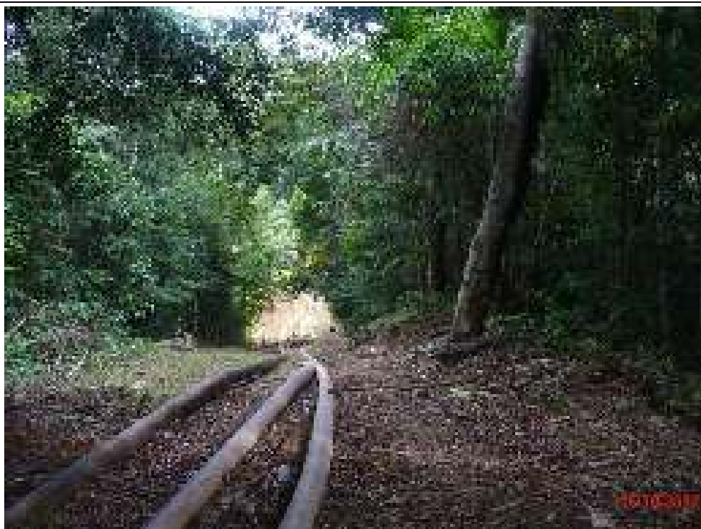
FOTO 21. Líneas de flujo de los pozos que se encuentran tendidos sobre la superficie del terreno y sin ninguna protección contra la corrosión.
