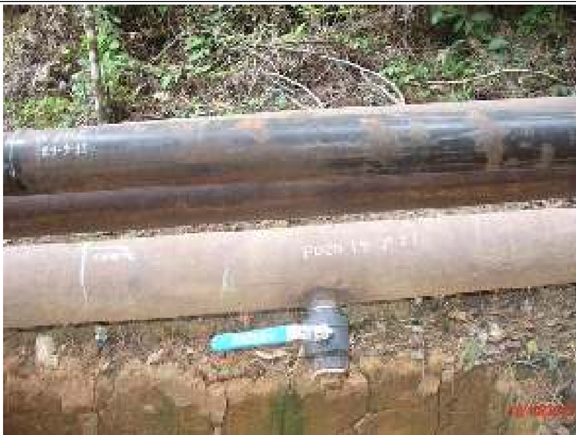
FOTO 23. Vista de la línea de flujo del Pozo CS 20 de reinyección del agua de producción con una válvula de 2"Ø y una tubería nueva para el cambio de tramo.
