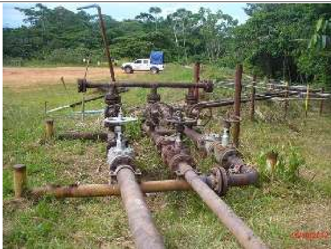
FOTO 20. Manifold a donde están conectadas las líneas de flujo de los pozos, al manifold le falta numeración de los pozos, sin protección contra la corrosión.
