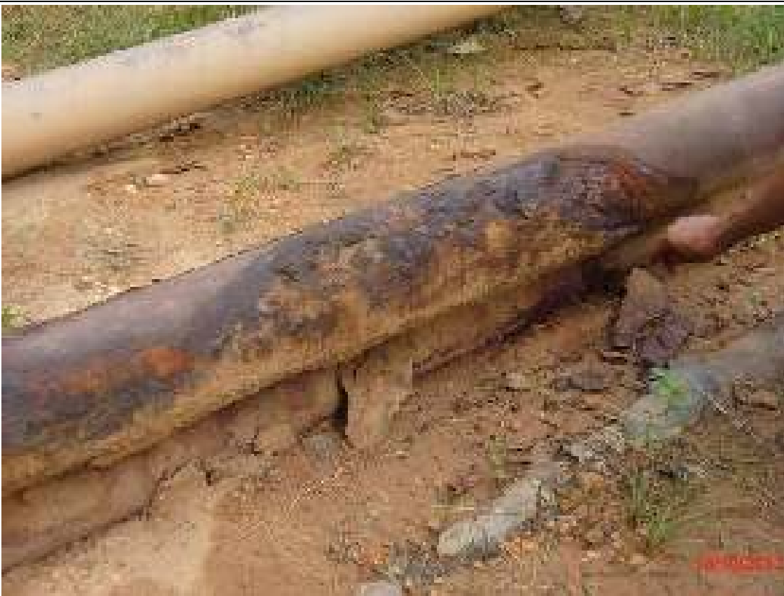
FOTO 26. Vista más cercana de la tubería en mal estado y se observa que la tubería operativa también tiene signos de encontrarse en mal estado.
