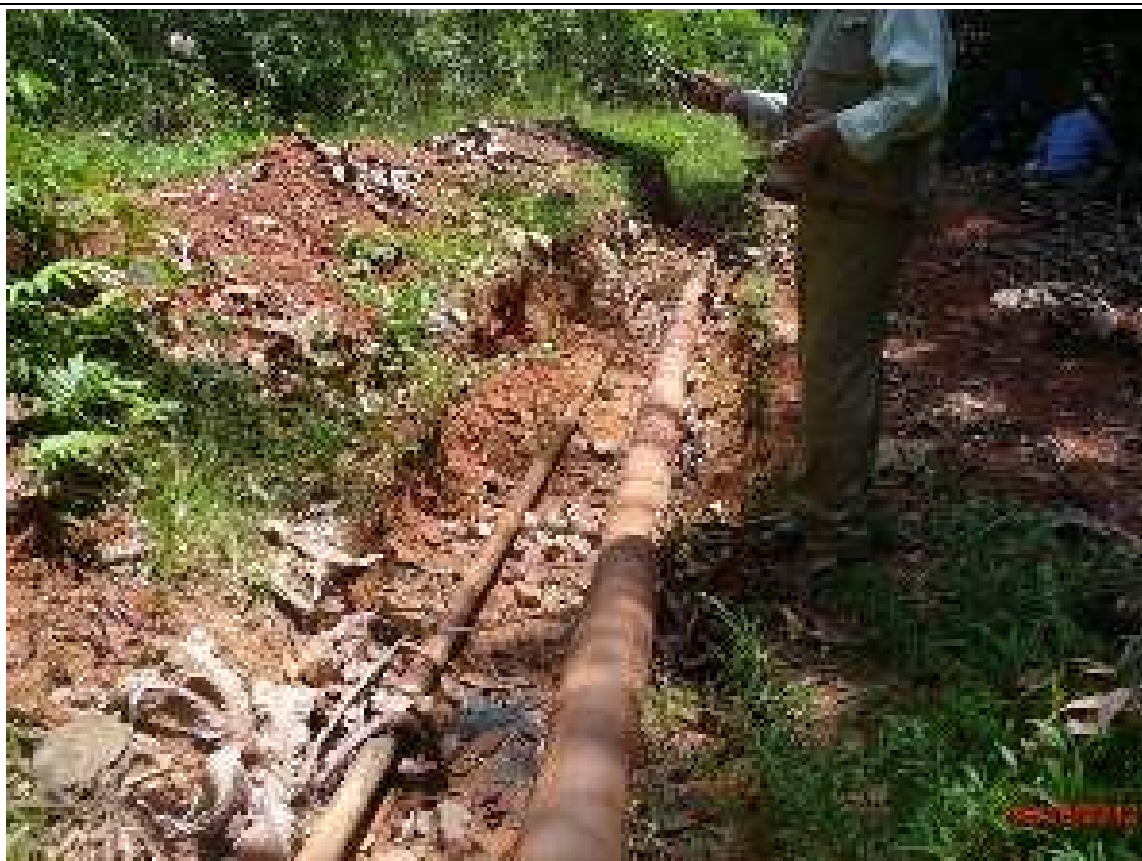
FOTO 6. Vista de la línea de flujo del Pozo CN08 que se evidencia signos de estar en mal estado
