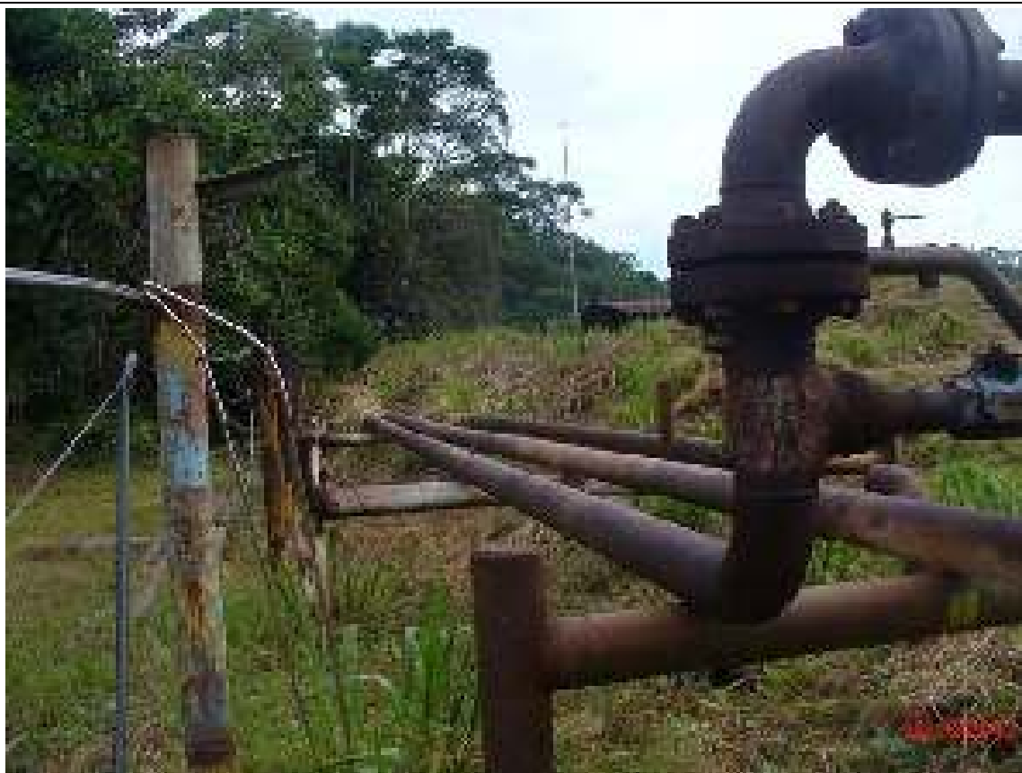
FOTO 19. Tramo al costado del terraplén donde se observa que esta parte está sobre soportes.
